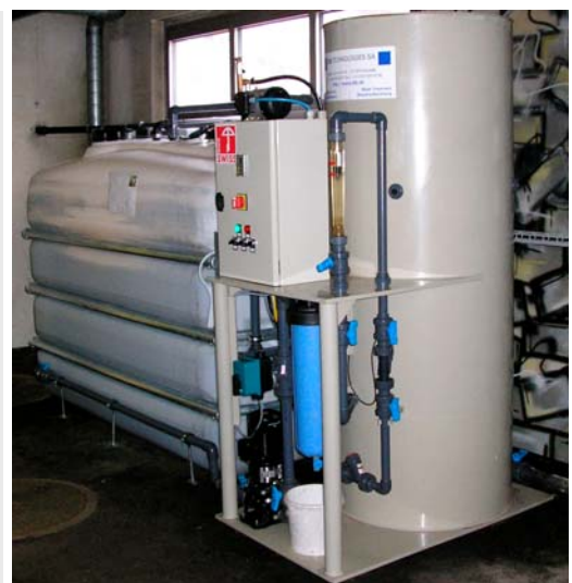
Bioréacteur DLK – FBR Easy Swiss avec 1 cuve de travail rectangulaire
